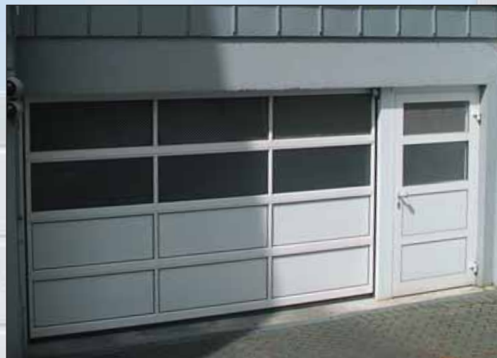
Sekční vrata SL s vedlejšími dveřmi, izodesky kombinované s mřížovinou v podzemní garáži.
