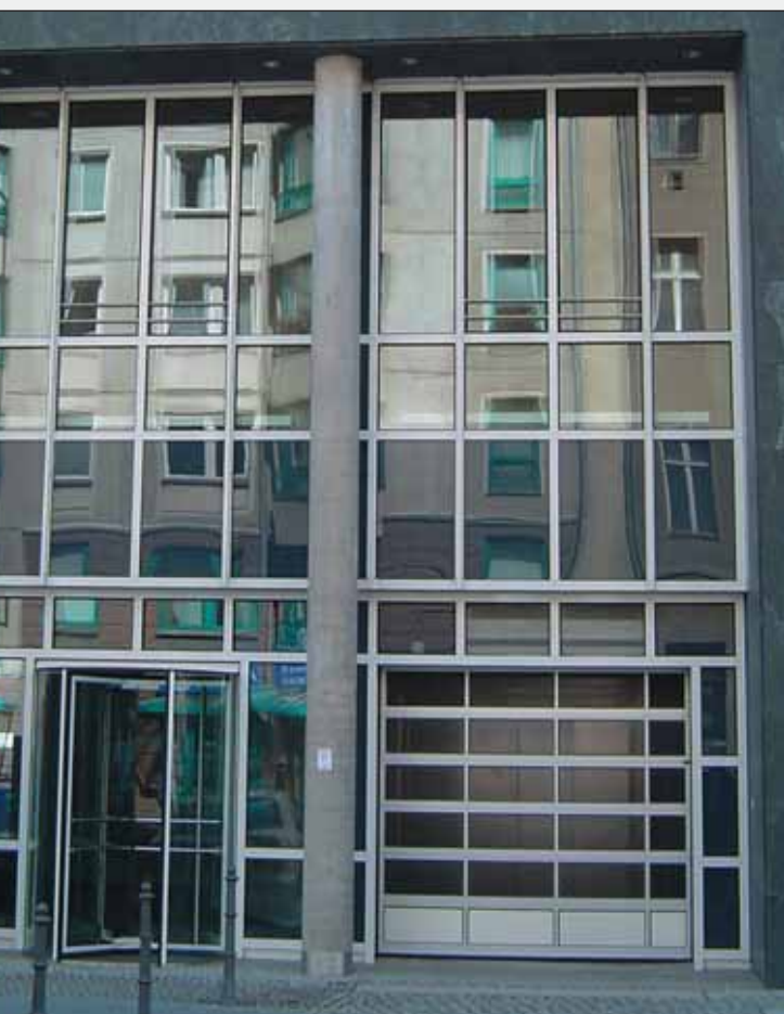
Sekční vrata SL, opticky integrovaná do skleněné fasády.
