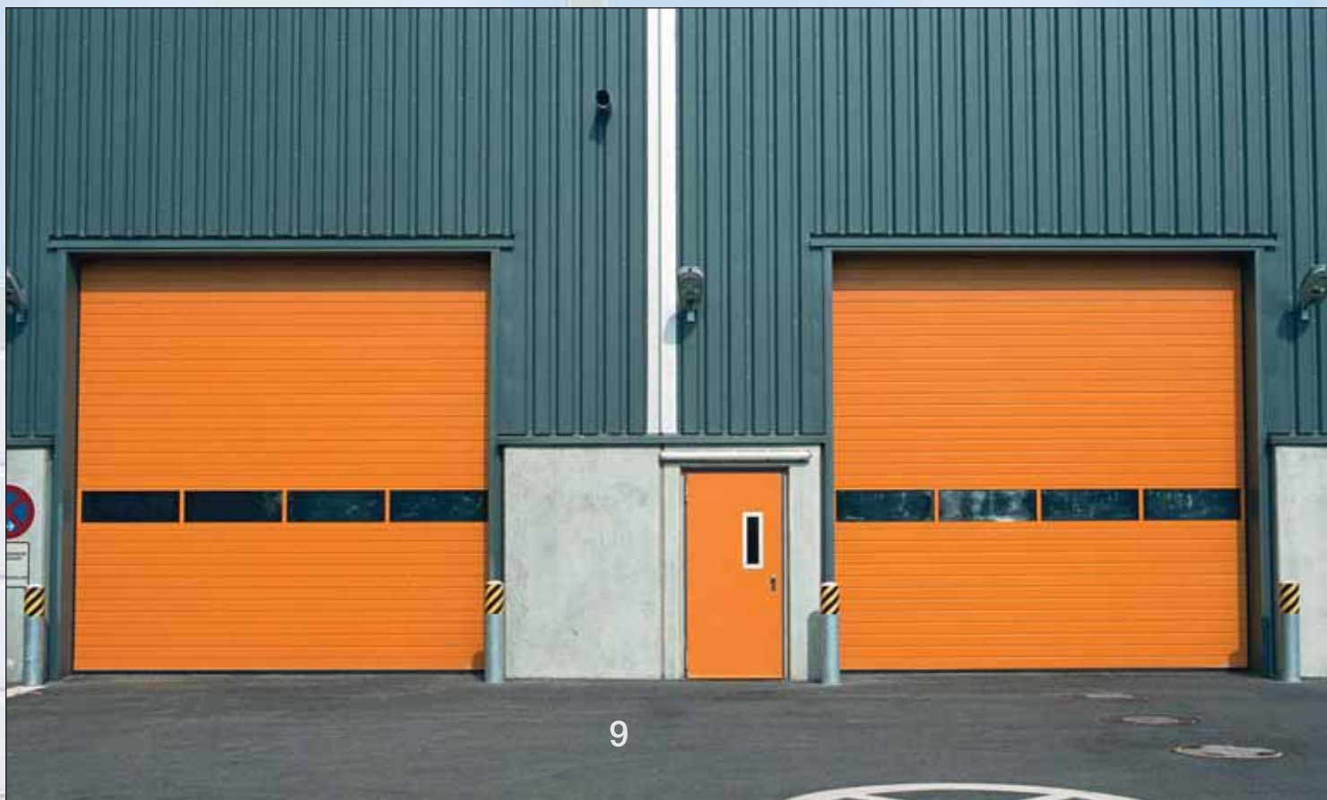
Sekční vrata SW, barevný povrch a vložená prosklená hliníková sekce.
