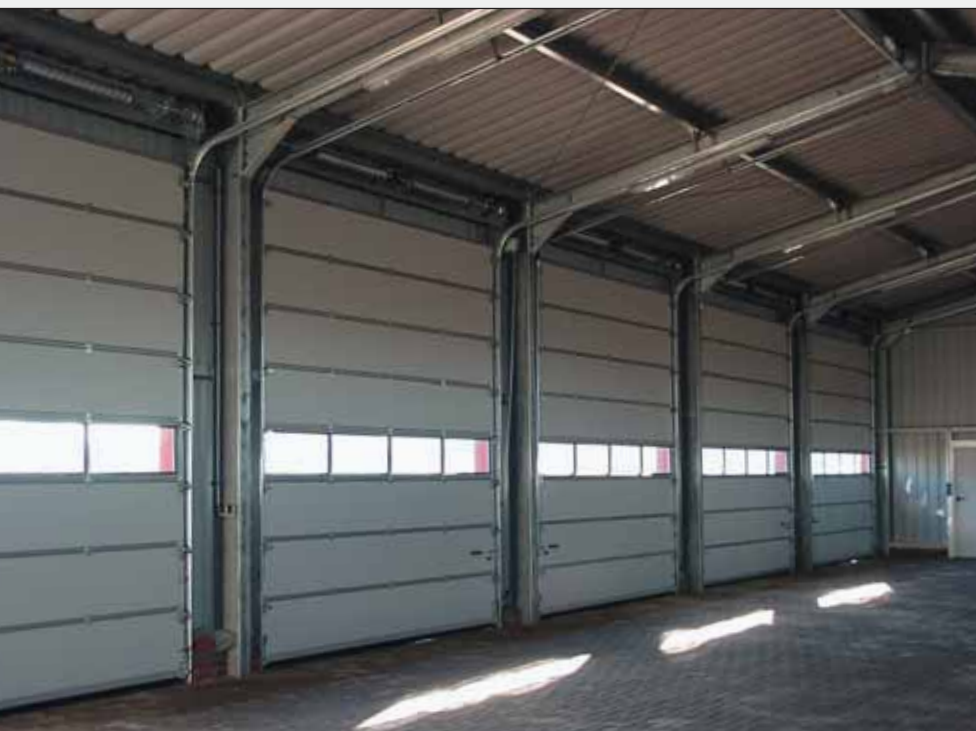
Sekční vrata SW se standardním kováním s kopírováním sklonu střechy.
